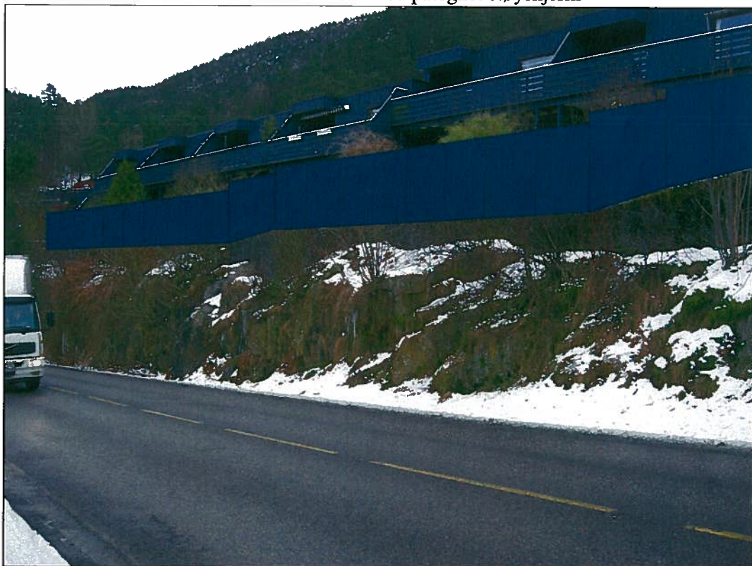
Bilde nr. 2 – Viser rekke C fra hovedveien med påtegnet støyskjerm
