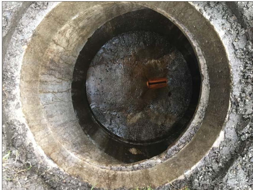
Foto: K1.JPG 40m, Inspeksjon fullført K1
