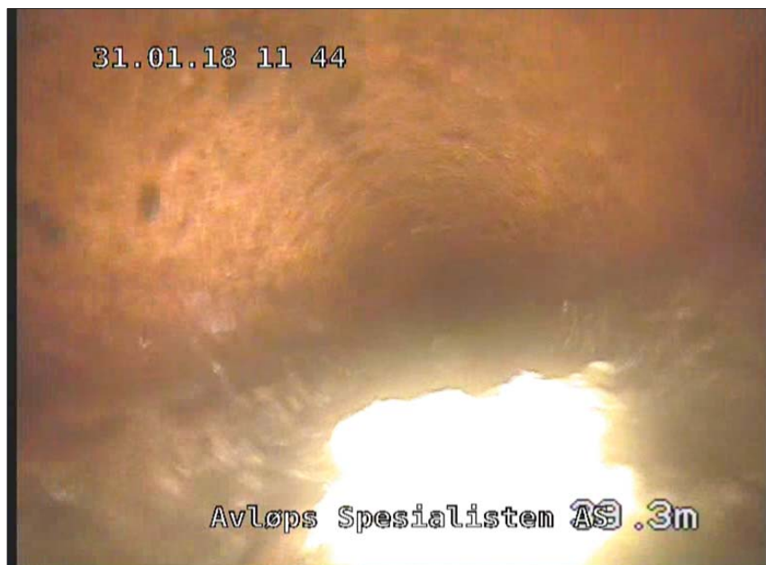
Foto: 5_1_23_08022018_113539_A.jpg 39,3m, Sedimentering, dybde på avsetning er mellom 5-15%, fra 04 til 08 Kl., Sanitaeravfall
