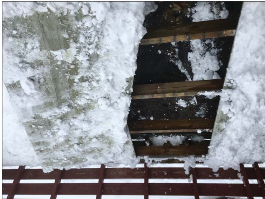
Foto: Oversikt K22 2bilde.JPG 0,01m, Korrosjon/Slitasje, Manglende tilslag (rørveggen er sterkt påvirket), I støpejernsrør er det kraftig rustangrep, fra 12 til 12 Kl., Start
