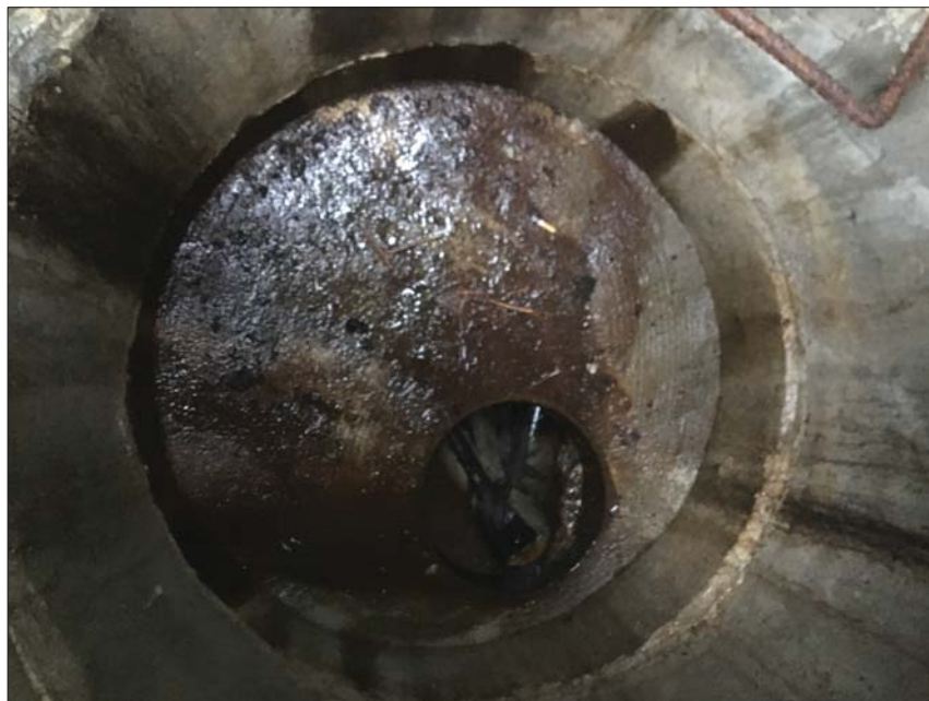
Foto: K2.JPG 0,4m, Retningsendring 03 Kl., Prefabrikkert bend
